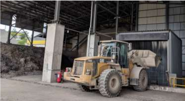
Bild 3: Das RDF kann an der Annahmestation auch mittels Radlader aufgegeben werden.
