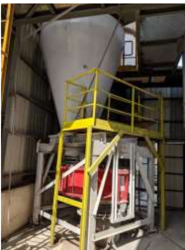
Bild 6: Das gravimetrische Dosiersystem ermöglicht eine konstante und gleichmäßige Beschickung des Vorwärmers.
